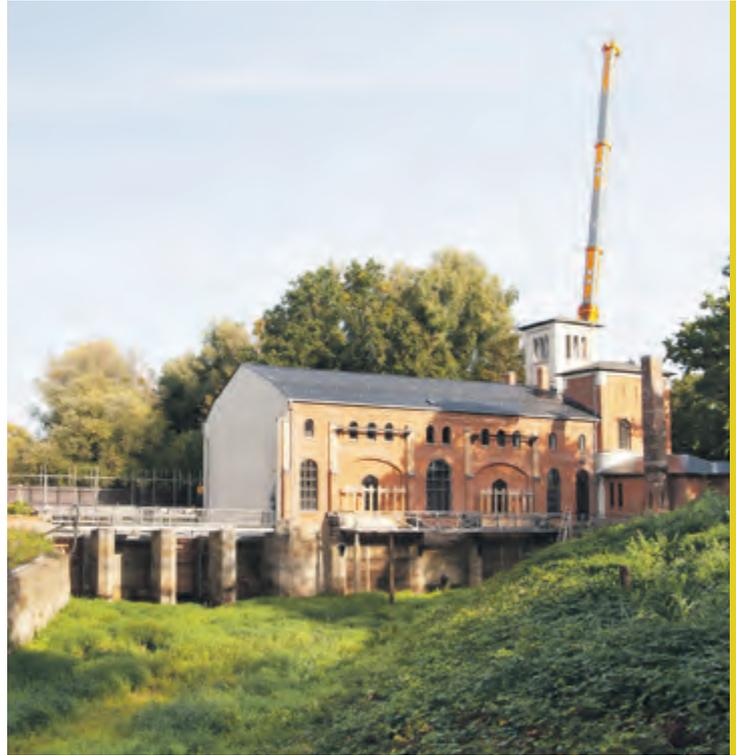
Ausgeführt wurden vor allem Sanierungsarbeiten von Fassade, WC, Fenster und Türen sowie Metall- und Schlosserarbeiten an den Wasserrädern und Pumpen sowie Erdarbeiten im UW und OW. Auch die angrenzende Wehranlage wurde saniert und im Bestand gesichert. Das Dach auf dem Hauptgebäude ist neu mit Schiefer eingedeckt worden. An der Fassade wurde der weiße Anstrich entfernt, so dass nun nach historischem Vorbild eine Gliederung von steinsichtiger, Naturstein- und Putzfassade entstanden ist.
