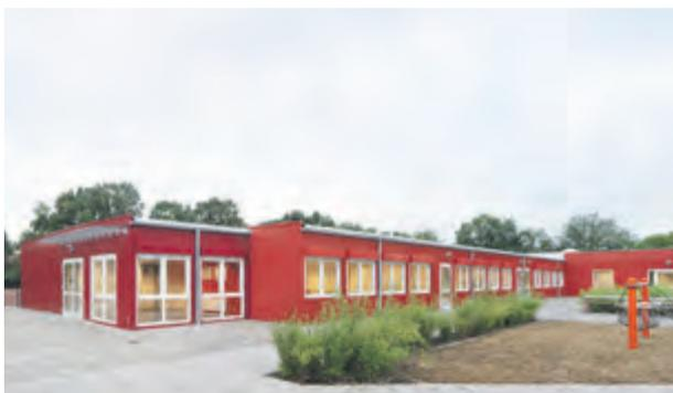
Das temporäre Schulgebäude wurde als U-förmige, eingeschossige Anlage in einer Kombination von 93 einzelnen mobilen Raumeinheiten errichtet, basierend auf 73 standardisierten Stahlcontainer-Abmessungen von 2,50 x 6,00 Meter sowie 20 flurbildenden Containern mit Breiten von 2,50 und Längen von 5,00 und 7,50 Metern.
