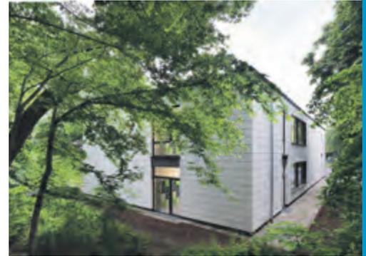
Für das Gesamterscheinungsbild IGS Linden wurde der Holzbau analog zu den vorgehängten weißen Leichtbeton-Außenschalen der Bestandsgebäude mit weißen hinterlüfteten Faserzementplatten verkleidet.
